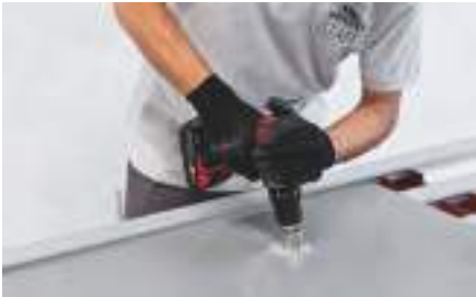
Per la realizzazione di fori si raccomanda l'uso di frese diamantate avendo cura di bagnare costantemente la superfice.
