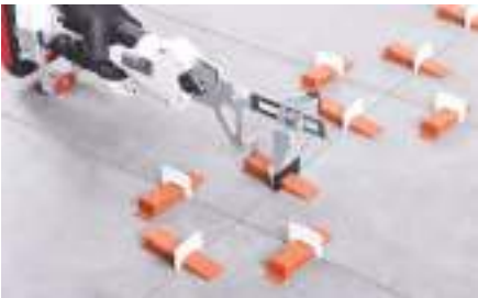
Utilizzare sistemi di livellatura per assicurare una installazione appropriata e rendere perfetta la planarità della superfice posata.
