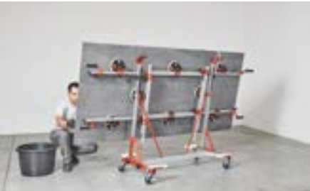
L'obiettivo da perseguire è lo strato compatto di adesivo, senza vuoti d'aria. Stendere l'adesivo con la tecnica della doppia spalmatura. L'adesivo deve essere spalmato, con idonee spatole, sempre parallelo al lato corto sia sulla lastra con spatola minimo dente 3x3, che sul fondo su cui va applicata con spatola minimo dente 10x10.
